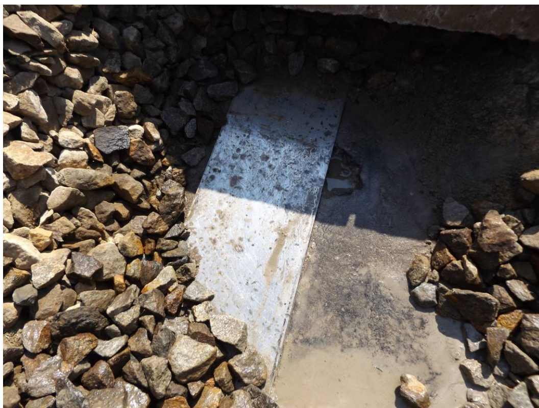
Obr. č. 8 - detail krytu dilatační spáry v kopané sondě KS3
