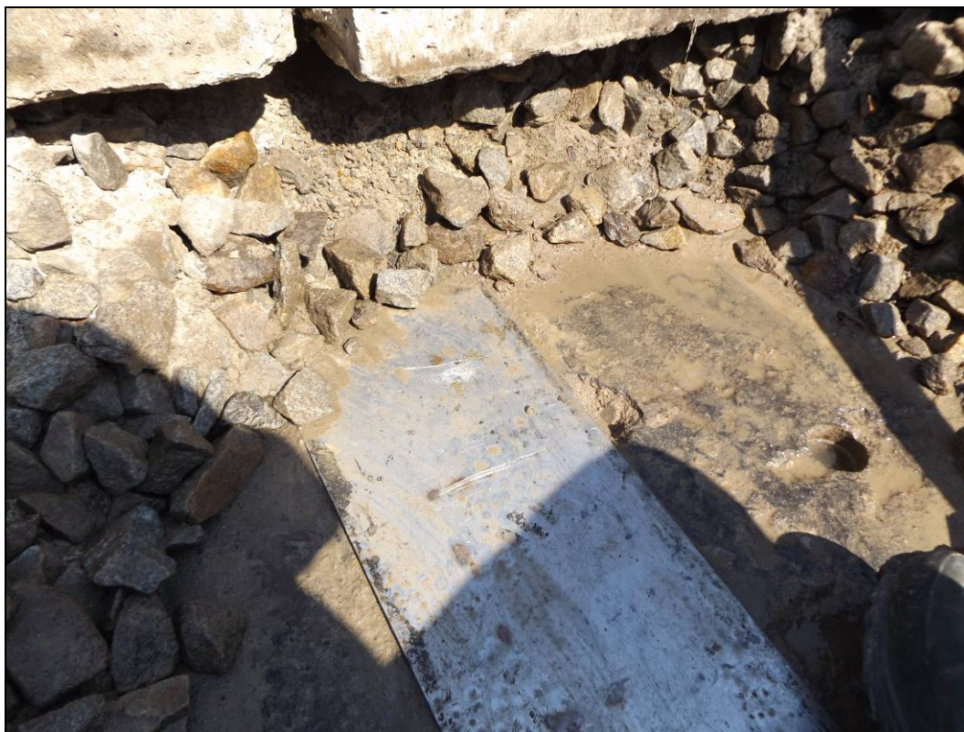
Obr. č. 5 - detail krytu dilatační spáry v kopané sondě KS1
